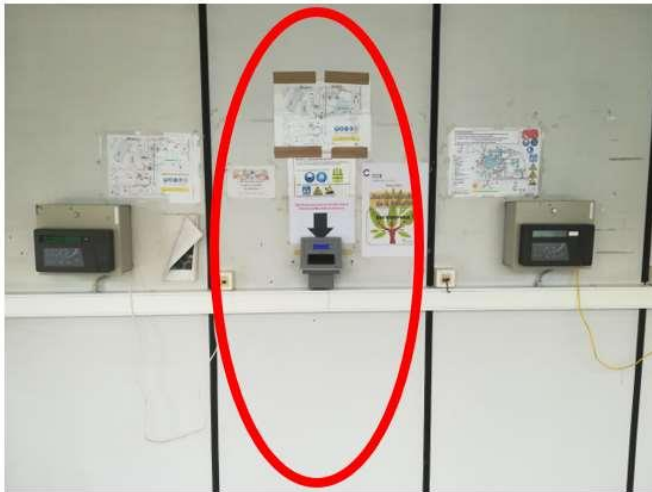
Local pointage firmes extérieures Emplacement de la nouvelle pointeuse
